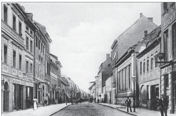
Wollenweberstraße mit Synagoge (rechts) ul. Wollenweberstraße z synagogą (po prawej)
